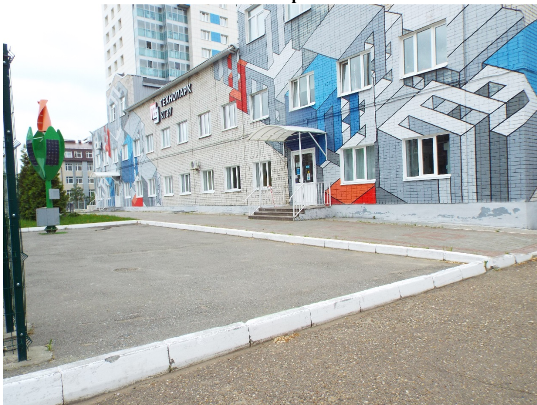
Фото Общий вид корпуса Г
