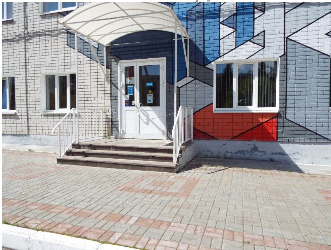
Фото Вход в корпус Г
