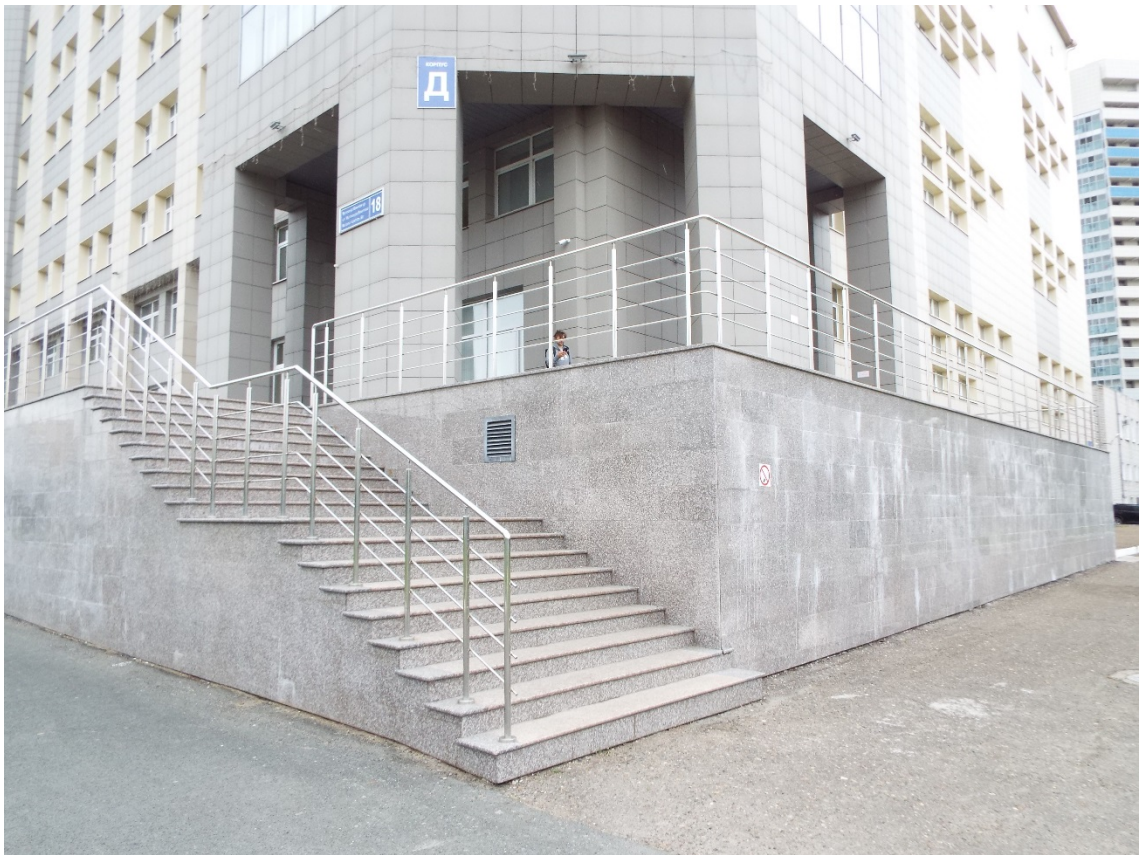
Фото Наружная лестница
