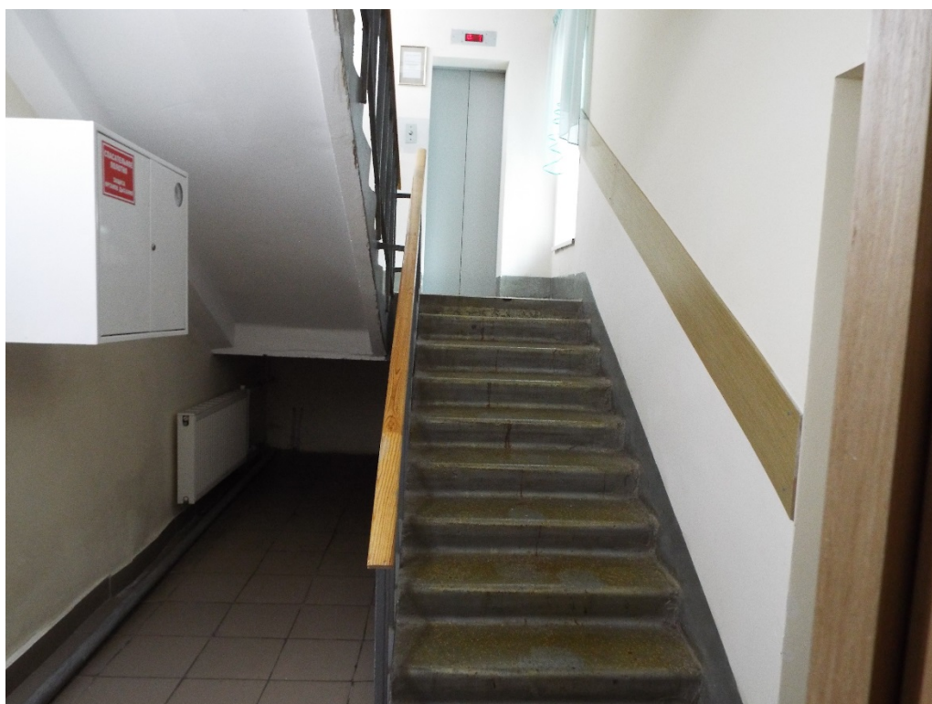
Фото Лестница на второй этаж
