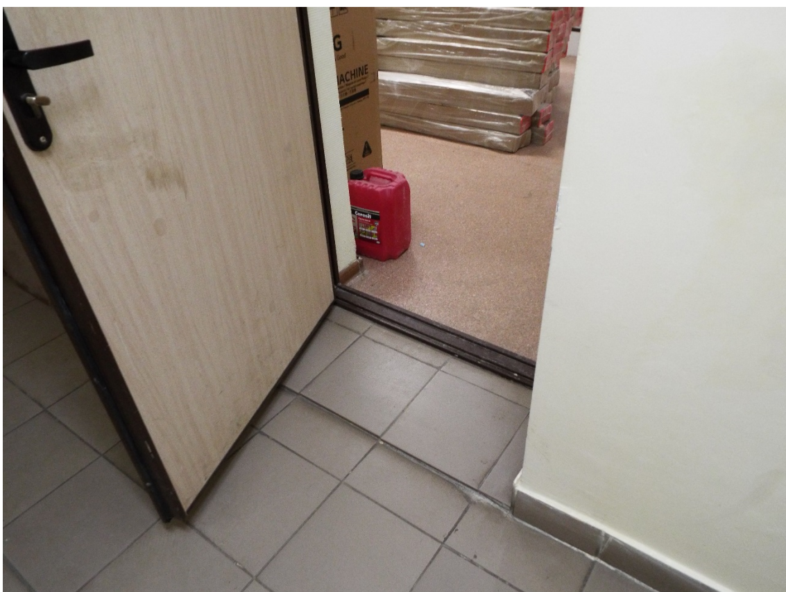
Фото Порог на входе в комнату для проживания МГН
