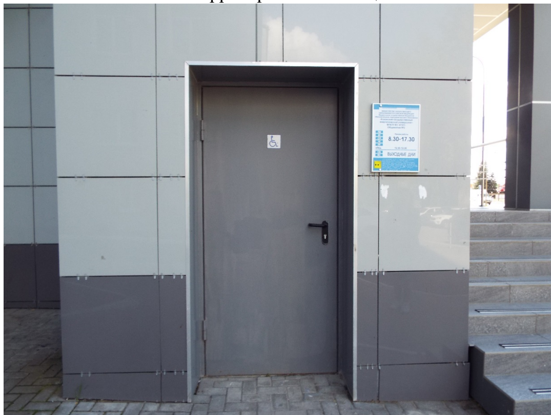
Фото Входная дверь для МГН
